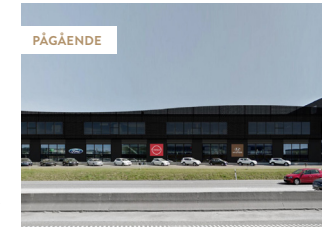
Vinkeln 6 JÖNKÖPING Ombyggnation kommersiellt Investering 11 Mkr
