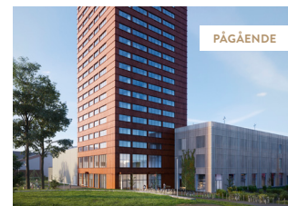
Värendsvallen 12 Nivika Center VÄXJÖ Nybyggnation samhällsfastighet Investering 90 Mkr
