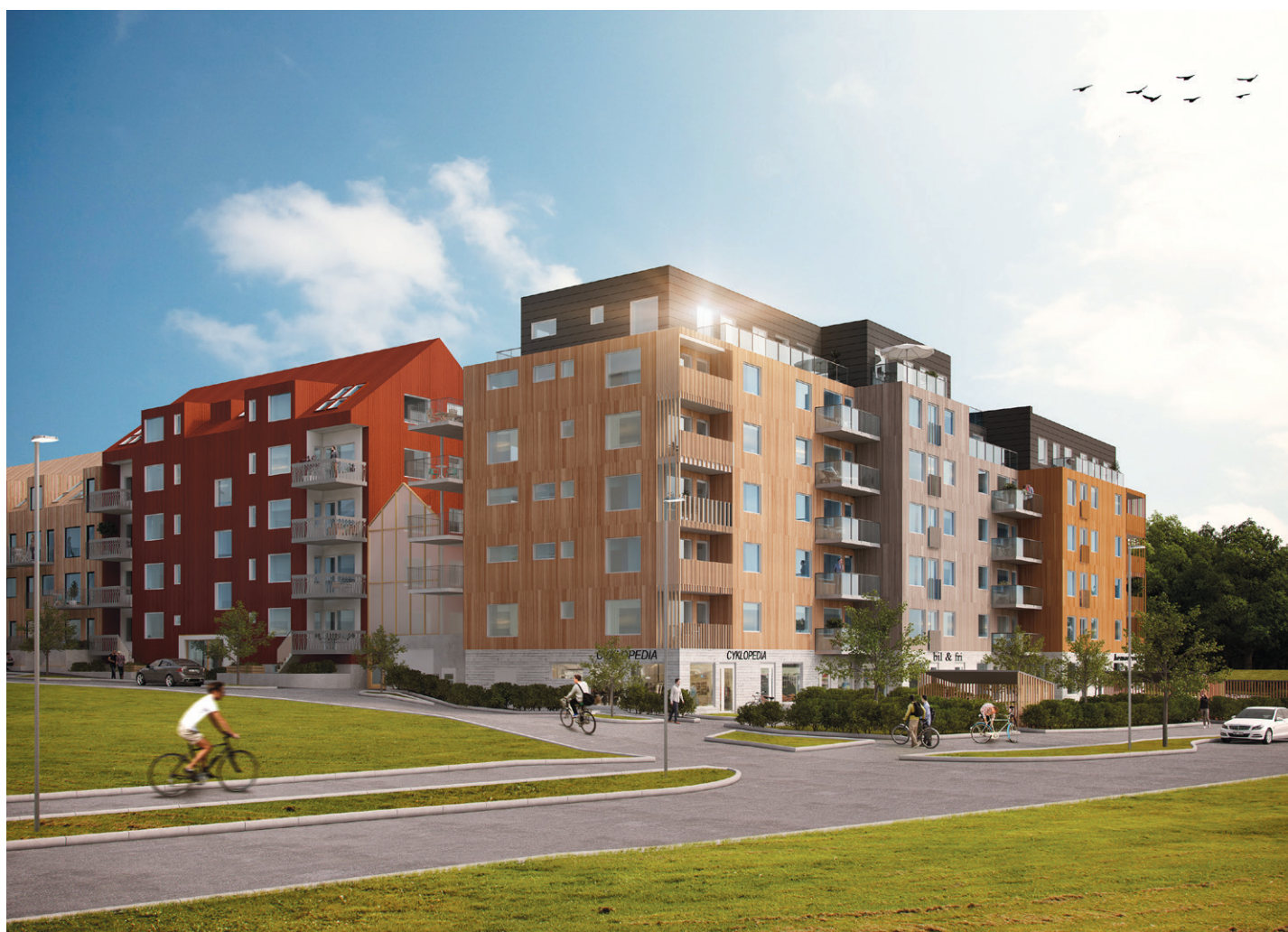
Kv Västergöken och Vråken, Kungsängen Jönköping
