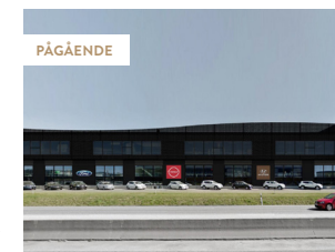
Vinkeln 6 JÖNKÖPING Ombyggnation kommersiellt Investering 11 Mkr
